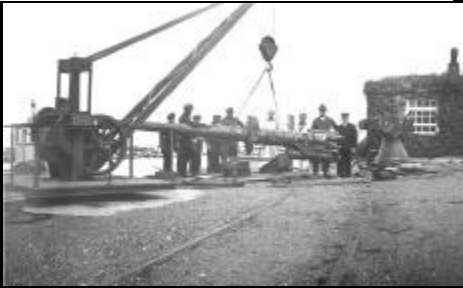
76mm kanon er ved at blive demonteret.
